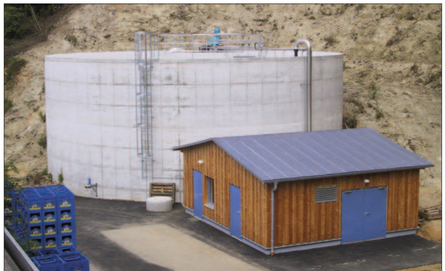
Abb. 1: Misch- und Ausgleichsbecken Brauerei Aldersbach
