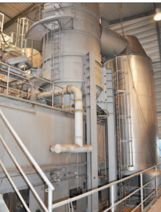
Kesselansicht bei Emter GmbH, Altenstadt
